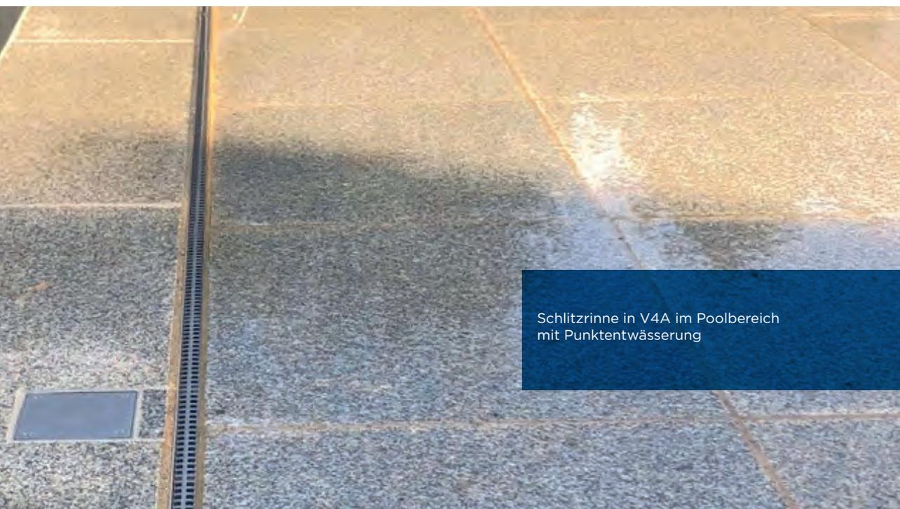
Schlitzrinne in V4A im Poolbereich mit Punktentwässerung
